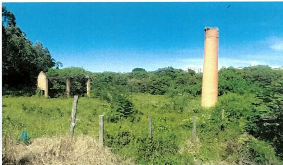
Foto 27: Vista da chaminé dentro do terreno.
