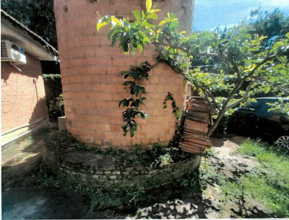
Foto 32: Vista da base da chaminé.
